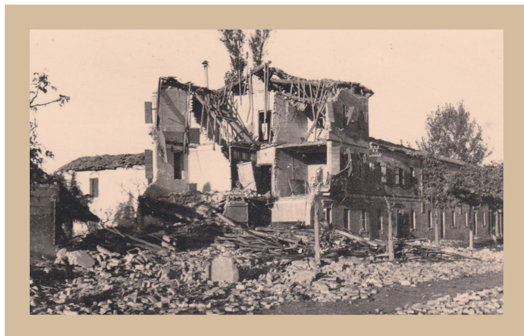
Viale Regina Margherita dopo il bombardamento dell'ospedale. Villa costruita di fronte all'ospedale. Foto archivio A. Battistella
