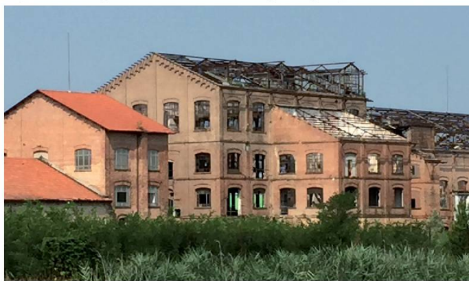
Condizione attuale dello Zuccherificio vista da Via Piavon
