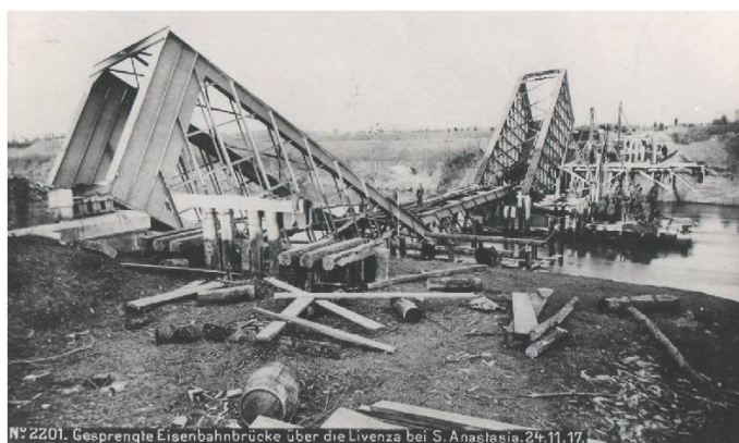
N° 2201. Gesprengte Eisenbahnbrücke über die Livenza bei S. Anastasia. 24.11.17.
