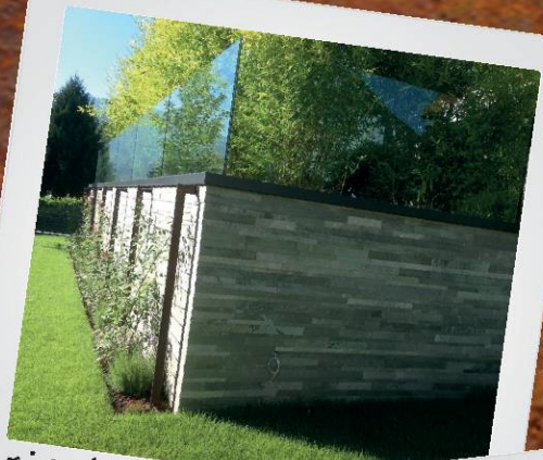
rivestimenti in corten e parapetti in vetro
