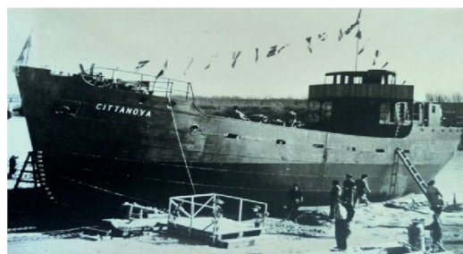
La motonave "Cittanova" vista di lato quasi ultimata con le maestranze al lavoro
