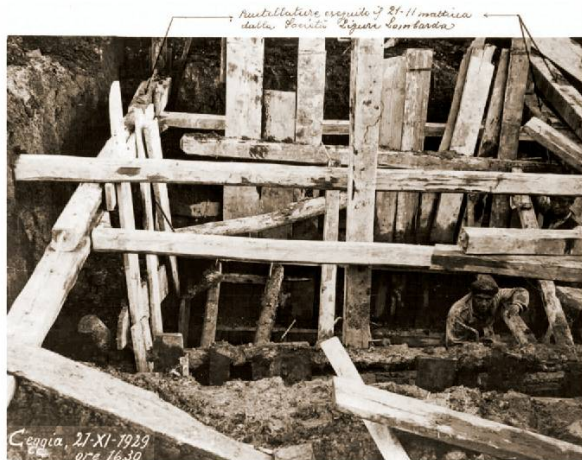
(21 Novembre 1929): Fondazioni. Nella fotografia sono indicate con frecce «Puntellature eseguite il 21-11 (1929) mattina dalla Società Ligure Lombarda». Questa nota lascerebbe intendere una partecipazione di tale Società, poi acquistata dalla Zuccherifici Nazionali.
